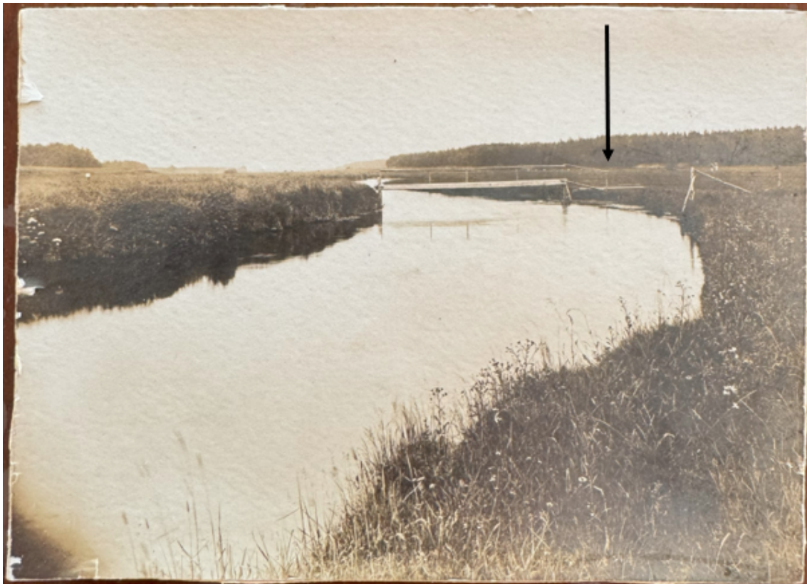
Ejers indsendte billede af bro og platform ved og over Gudenaåen. Sort pil peger på platformen.
