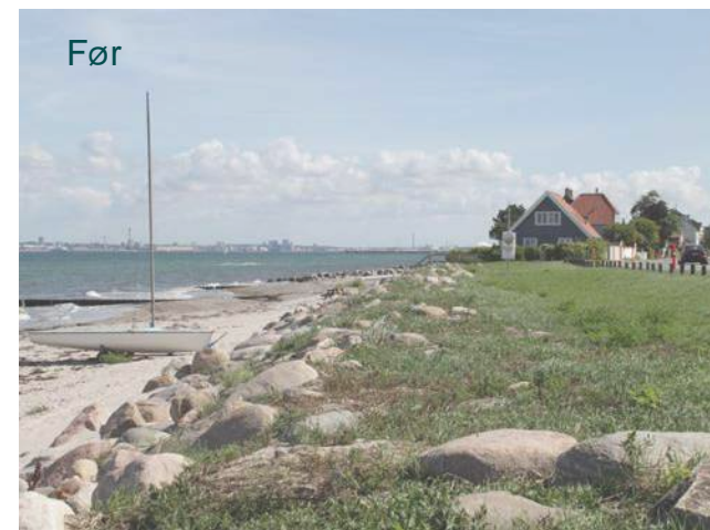
Eksempel hvor stensætning er blevet grøn som følge af ålegræs som vækstfacilitator
