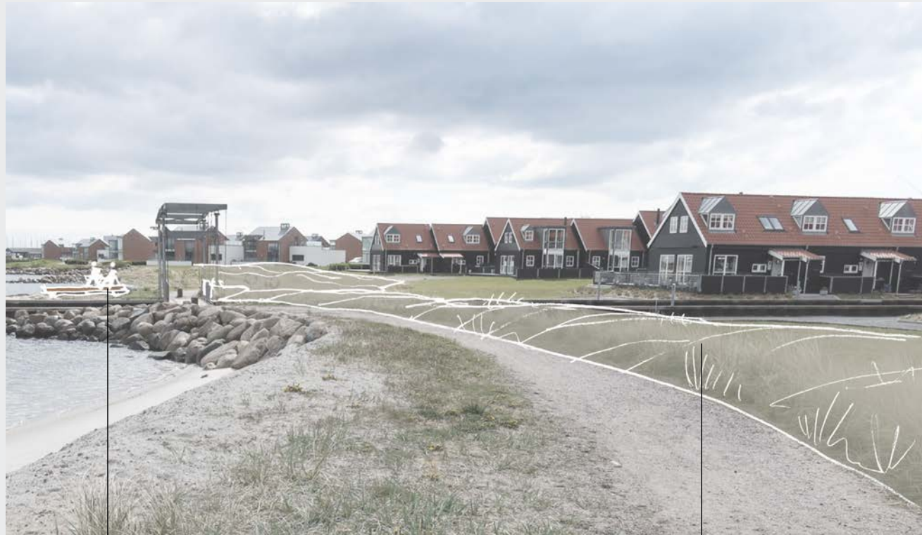
Sluseport kan bruges som udsigtsterrasse om sommeren
