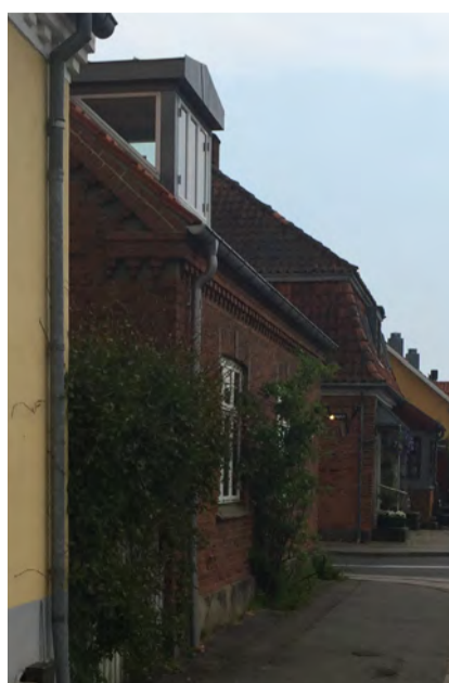
Klatreplanter på facade
