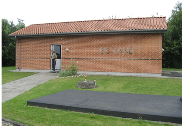
Figur 1: Øster Snede Vandværk. Foto fra tilsyn i 2010.
