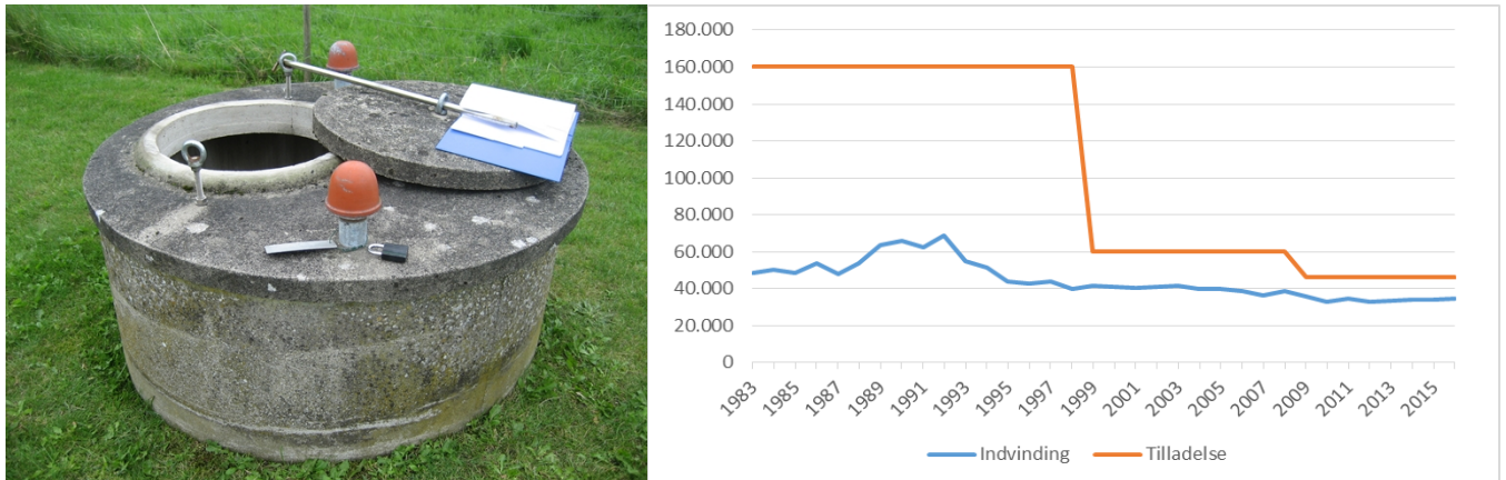
Figur 2: Indvindingsboring DGU nr. 116.1210 samt kurve med indvindingsmængde (til 2016).
