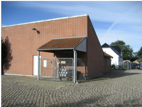
Figur 1: Løsning Vandværk. Foto fra tilsyn i 2010.
