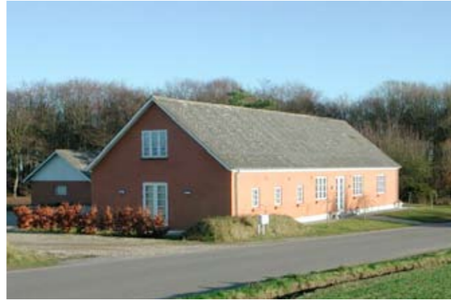
Nyrestaureret klassisk længehus, som er forsynet med nye vinduer, hvor der er taget afsæt i det for landsbyerne karakteristiske småsprossede look. Bemærk, at der på trods af forskelligartede vinduesformater er skabt en vis symmetri i facaden, ligesom der er harmoni med garagens farve og taghældning.
