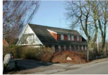
Vinduerne i kvisten er helt ude af takt med vinduerne i underetagen. Desuden er kvisten overdimensioneret i forhold til huset og farvekontrasten mellem kvist og gavl temmelig markant.
