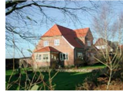
Ved denne fine tilbygning, som ganske vist har anderledes taghældning end hovedhuset, er det alligevel ved størrelse, materialevalg og udformning af vinduesformater lykkedes at få harmoni mellem de to bygningskroppe og tilbygningen slører på ingen måde det oprindelige hus, der er fra »Bedre byggeskik« - perioden
