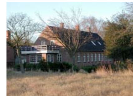
Tilbygningens form, vinduesformater og den voldsomt overdimensionerede altan misklæder det ellers meget smukke hus, der har et klassisk helt rytmisk facadeudtryk med lige store afstande mellem murpiller og vinduer.
