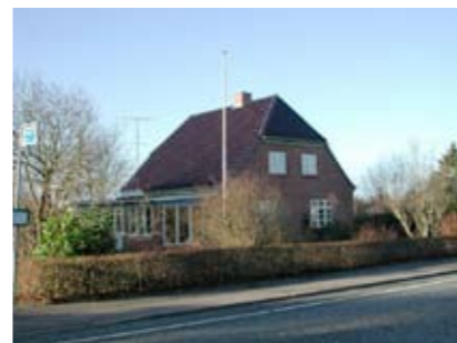
Havestuen er utilpasset til dette i øvrigt meget smukke hus fra perioden med »Bedre Byggeskik«. Lette transparente drivhuslignende konstruktioner kan virke distraherende i forhold til det oprindelige hus.
