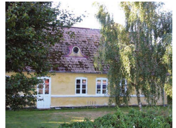
I landsbyerne findes ofte mange ældre meget smukke huse, som bl.a. på grund af deres detaljerigdom er bevaringsværdige. Her en meget speciel kvist.
