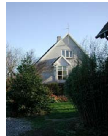
Mindre vindfang tilpasset fint til hovedhuset med samme taghældning og materialer.
