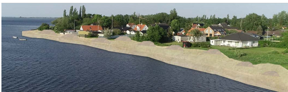
Figur 6 Højvandsbeskyttelse i form af en klitrække
