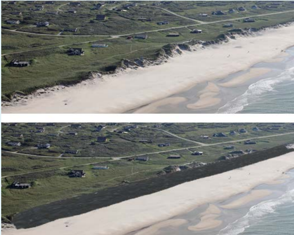
Figur 4 Kystens visuelle udtryk før og efter anlæggelse af skråningsbeskyttelse i sten
