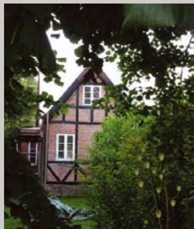
Bindingsværkshusene i landsbyen er meget forskellige. Her med fyldninger i rød tegl
