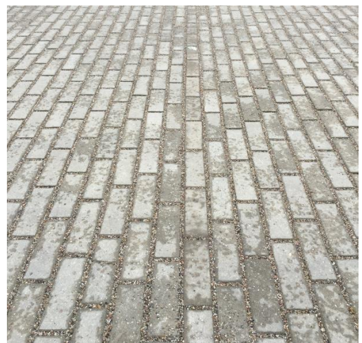
Permeabel belægning. Foto Hedensted Kommune
