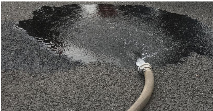
Permeabel asfalt er fast overflade hvor vandet kan sive igennem. Foto Hedensted kommune
