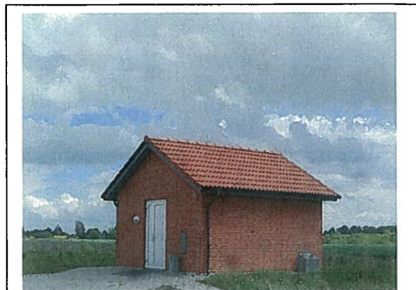
Øster Ørum vandværk (ny). Indsatsplanen skal medvirke til, at vandværket kan bestå i fremtiden
