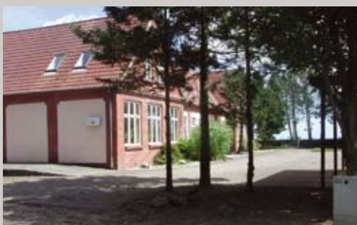
På Holstdalsvej 16 ligger virksomheden Thestrupgaard i denne ældre murstensbygning.
