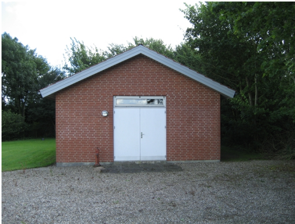
Figur 1: Solkær Vandværk. Foto fra tilsyn i 2010.
