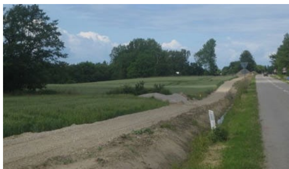
Etablering af cykelsti over marker langs en landevej
